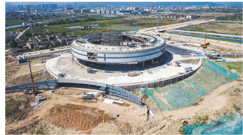
正在建设中的中交未来城 (本文图片由浙江宁波市奉化区委改革办提供)
