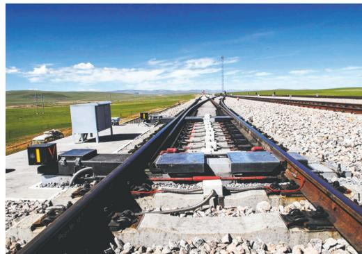
在青藏铁路昆仑山东段、格尔木市辖内的玉珠峰站至拉萨市当雄站之间，安装了道岔融雪设备，通过数字传感器技术和计算机自动控制技术传递下雪、停雪信息，通过远程控制加热系统，实现自动融雪，保证降雪时段车站道岔能顺利转动。该系统是首次在中国铁路线上正式使用。
