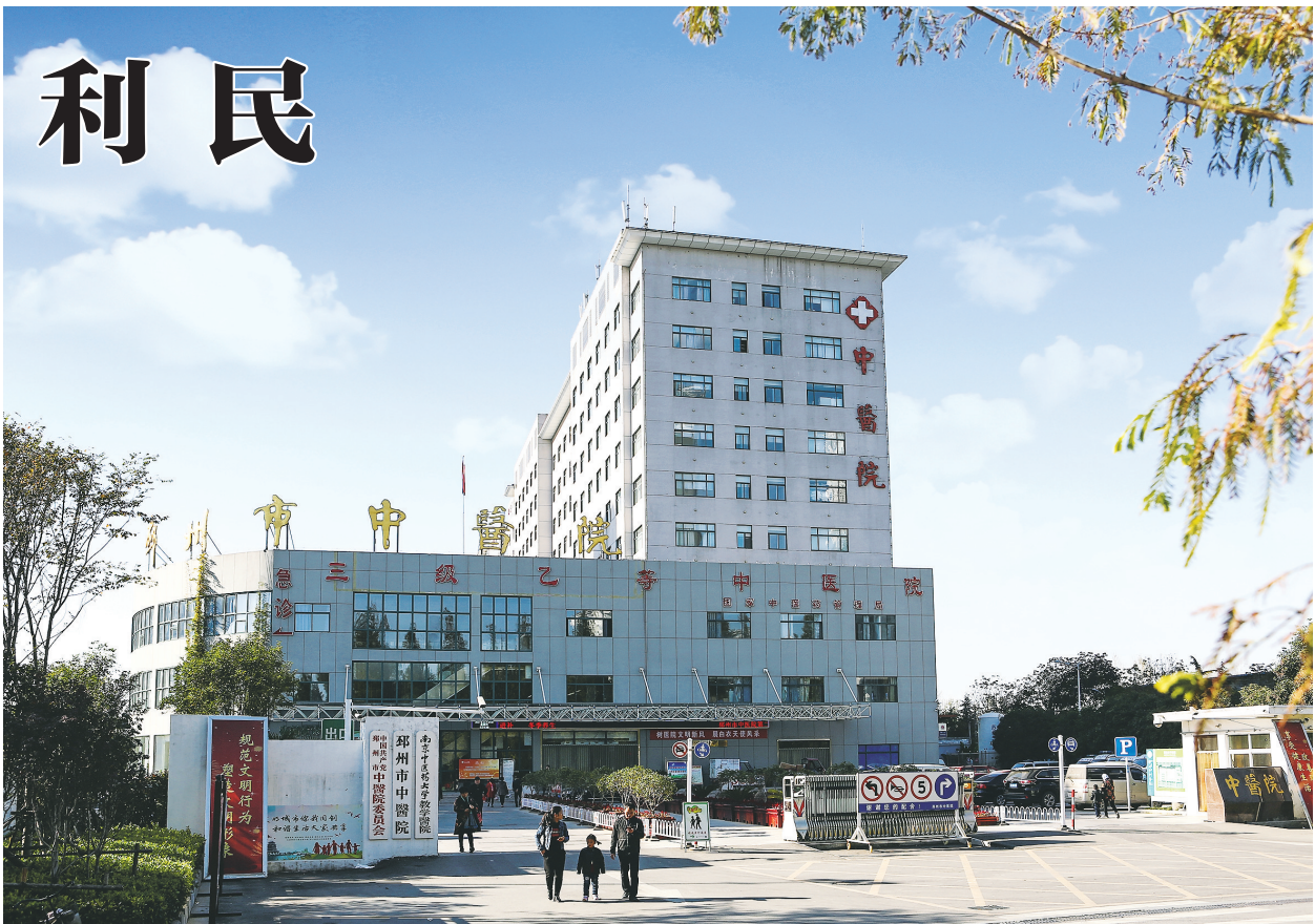
邳州市中医院门诊大楼
