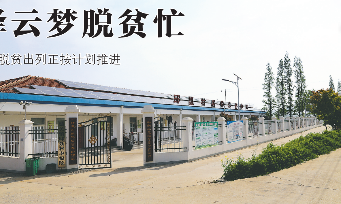
云梦县城关镇邱聂村居家养老中心
