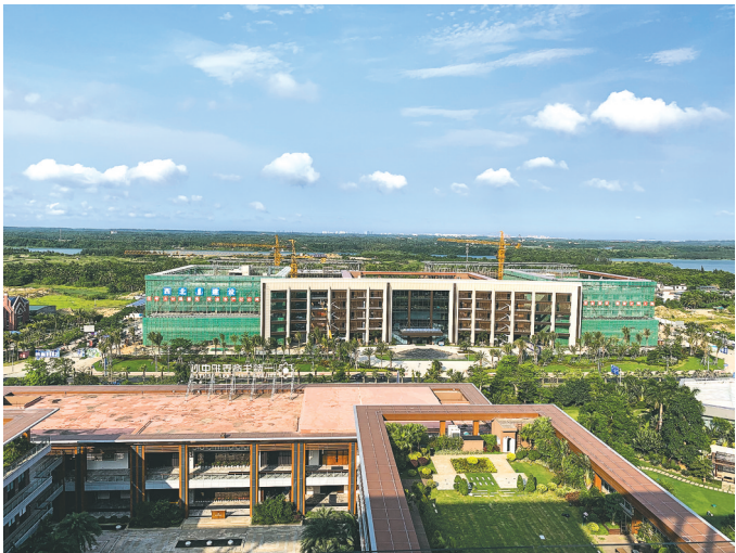
正在建设中的博鳌乐城国际医疗旅游先行区
