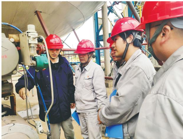
河南能源贵州黔希化工安全联合检查人员正在乙二醇装置现场检查仪表调节阀
