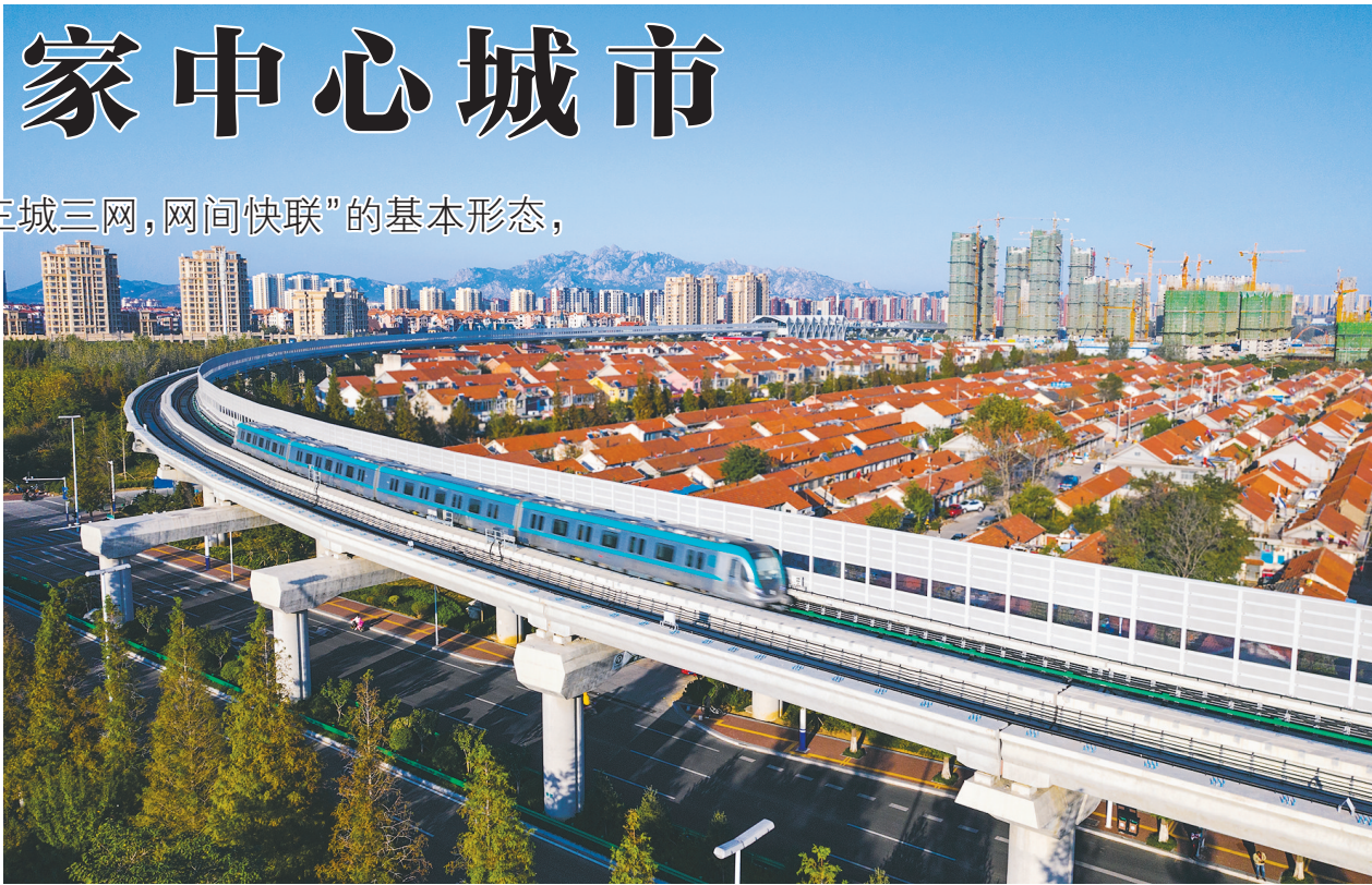
13号线高架航拍图
