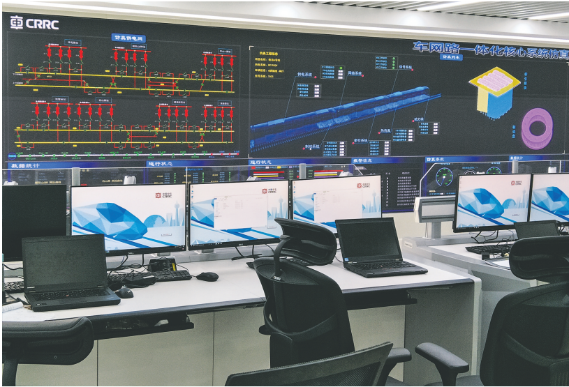
青岛TACS联调联试集中控制与显示中心
