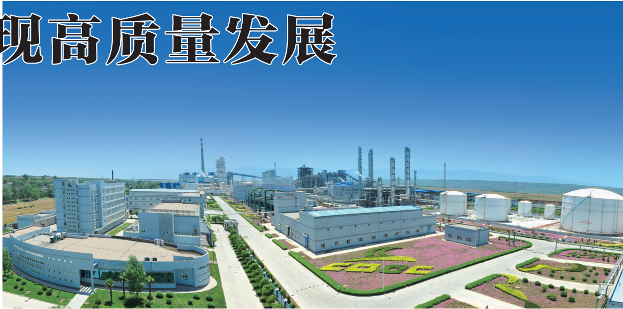
2017~2018 年度全国甲醇行业优秀企业——徐矿集团陕西长青能源化工有限公司,运营质量和效益水平位居全国同类型装置第一。
