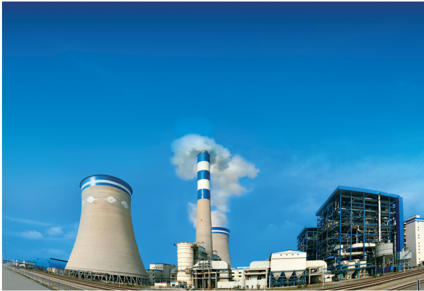
火力发电、科技领先——徐矿集团江苏华美热电公司,建成江苏首家可连续运行烟气“脱白”项目。
