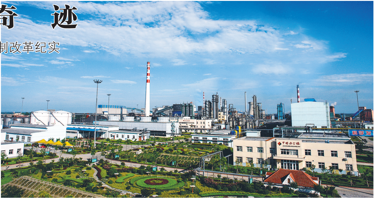
盛隆化工有限公司厂区
