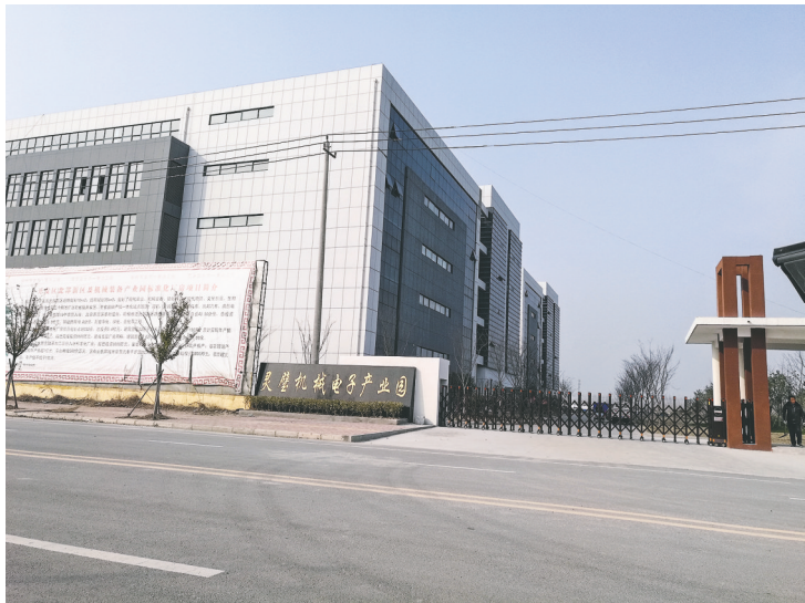
灵璧机械电子产业园
