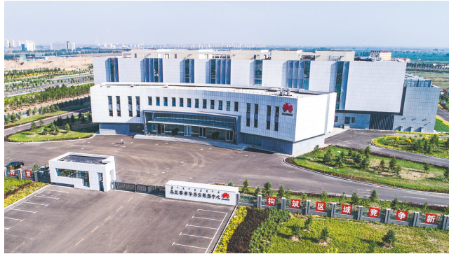
乌兰察布华为云数据中心外景 段建宁 摄
