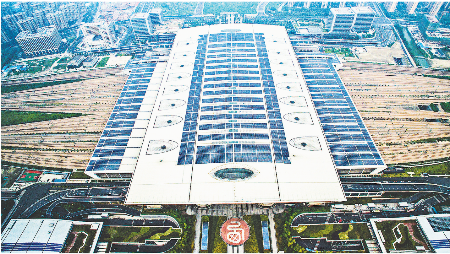
正泰杭州火车站10MW屋顶光伏电站
