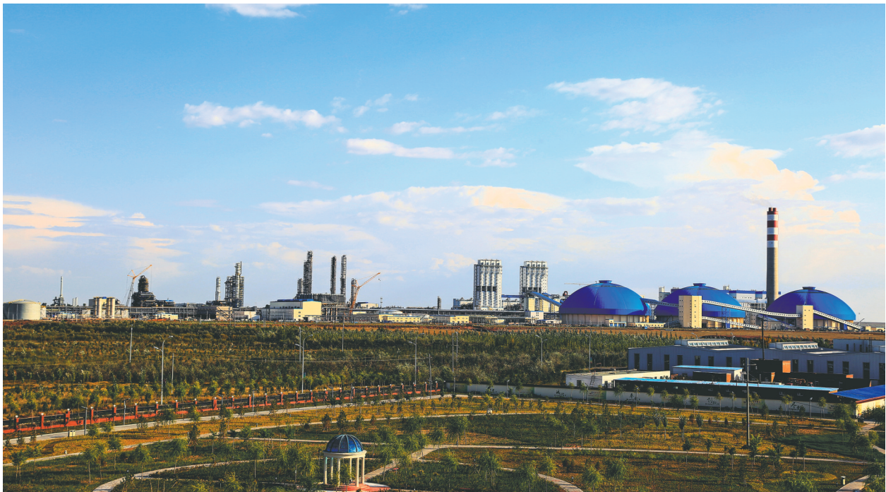
伊泰集团年产120万吨煤基精细化学品示范项目
