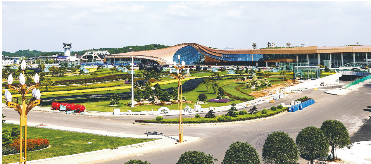
凤凰机场新航站楼投入使用,为铜仁走向世界插上翅膀。
