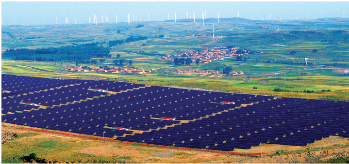
设计建设的张北国家风光储输示范工程获菲迪克优秀工程奖
