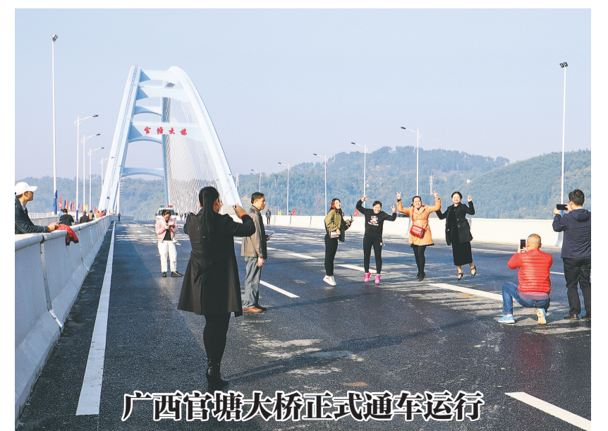
近日,中铁上海工程局承建的柳州官塘大桥正式通车运行,整桥主线全长1155.5米,水中不设桥墩,跨度达457米,是目前世界第一大跨度有推力钢箱拱桥,世界第九大跨度钢箱拱桥。图为当地市民拍照留念。(石 硕)
