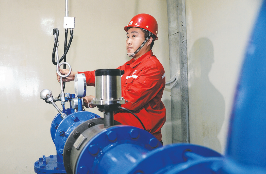
截至2017年年底，中国石化已在雄安新区范围内签约供热面积738万平方米，建成供热能力602万平方米。（中国石化供图）
