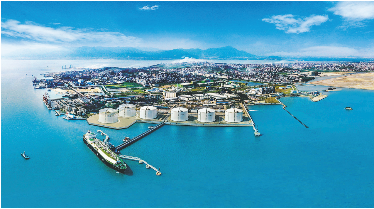
国家有关部门有条不紊谋划,央企和民企对LNG接收站密集投建,都为下好“天然气保供”这盘“大棋”做了充分准备。图为中国海油气电集团天津LNG码头。(中国海油气电集团供图)
