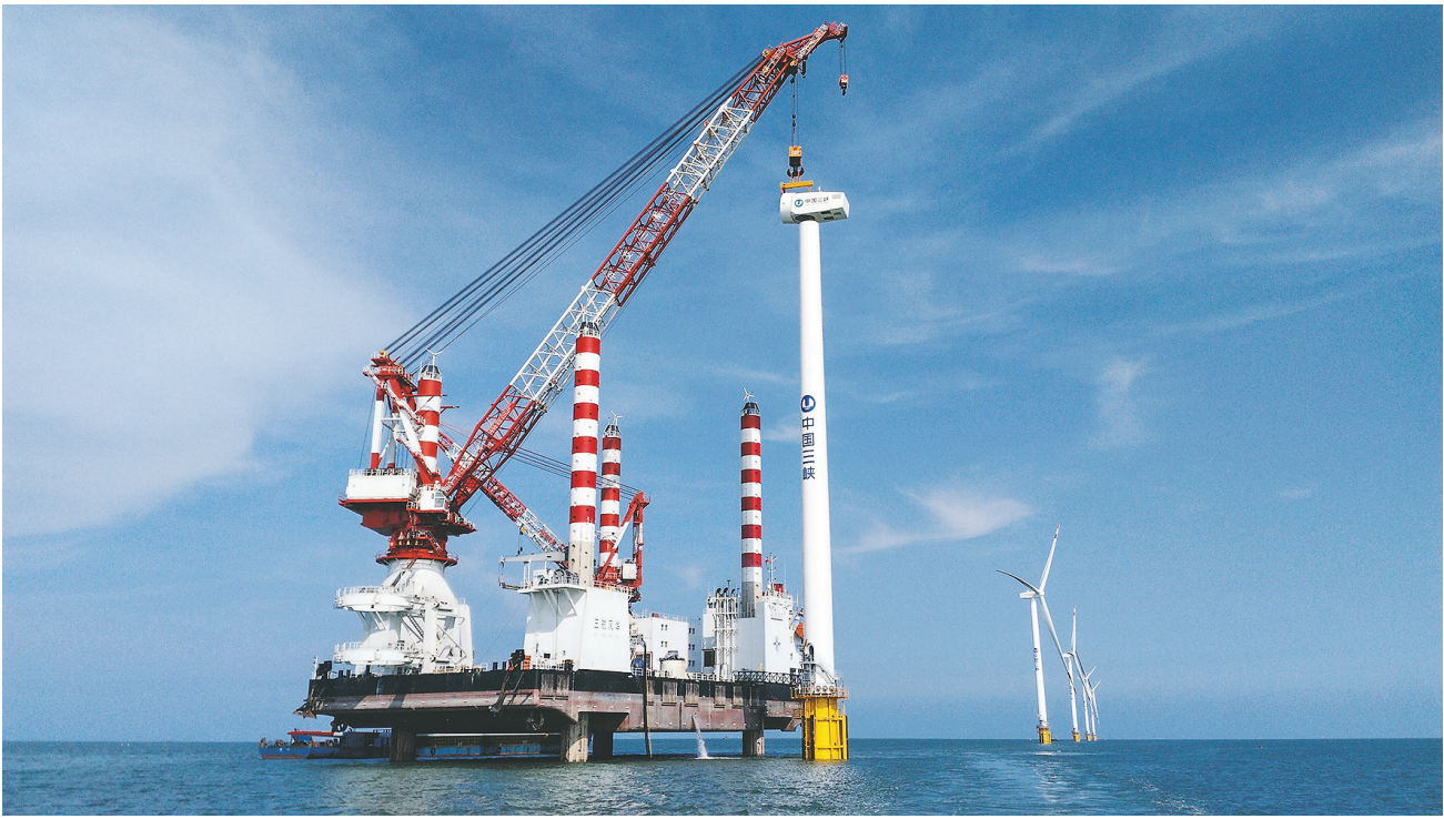
到2017年,全球可再生能源消费占比达到10.4%,中国的可再生能源消费占比达到11.7%,高于全球可再生能源发展的水平。图为直径130米、重达100多吨、距离海面约30多层楼高的“巨无霸”风机在江苏响水海上风电场吊装。(中国三峡集团提供)
