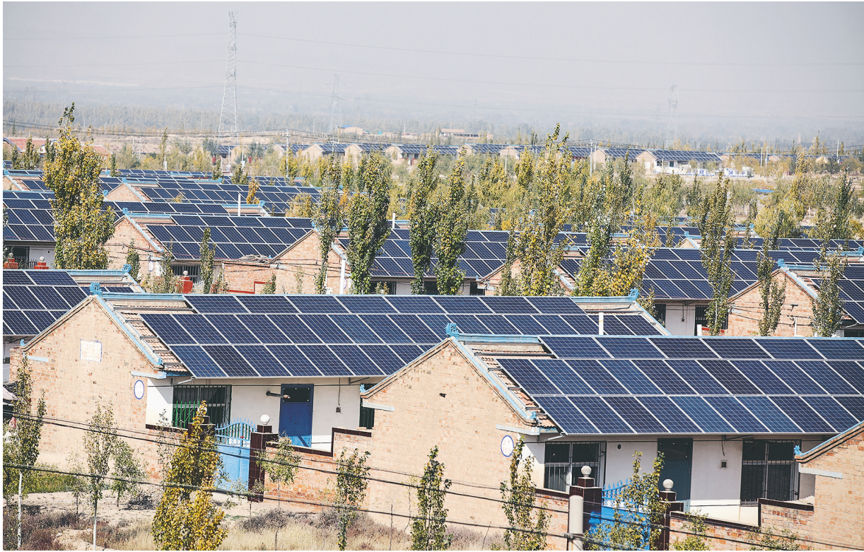
分布式光伏发电具有就近利用清洁能源资源,能源生产和消费就近完成,能源利用率高、污染排放低等优点,代表了能源发展的新方向和新形态。图为宁夏中宁县红梧村10兆瓦分布式光伏发电项目。
