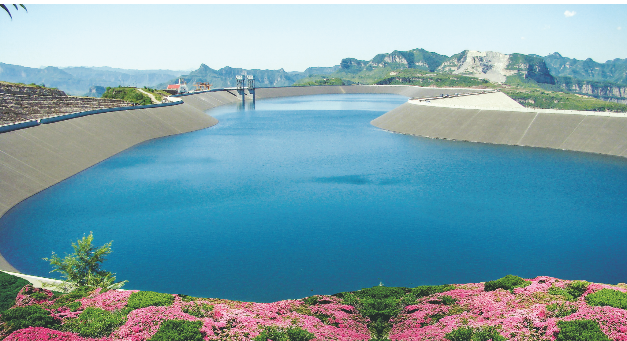
水电总院建60多年来始终从事中国水电、风电等新能源和可再生能源行业的技术管理工作。图为该院勘测设计的张河湾抽水蓄能电站。
