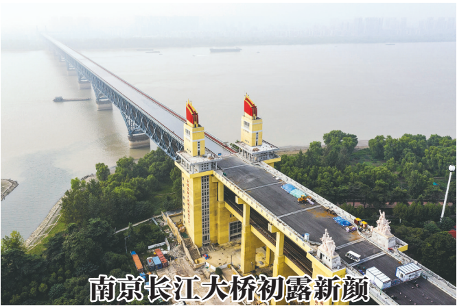
日前,正在进行维修改造工程的南京长江大桥公路桥桥面开始摊铺沥青,桥头堡及雕塑等处的围挡已拆除。南京长江大桥建成于1968年,公路桥于2016年10月28日开始封闭维修,预计2018年年底前完成维修改造,恢复通车。图为封闭维修中的南京长江大桥。 新华社发(苏 阳 摄)
