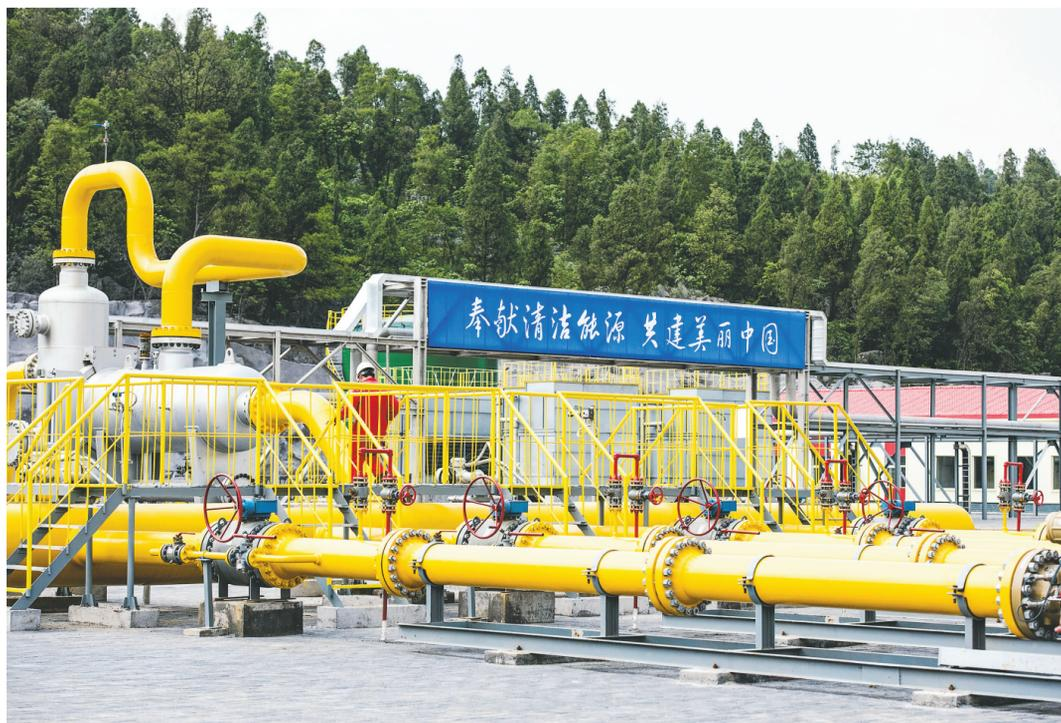
守住我国天然气发展的安全底线,保证天然气安全平稳供应,满足人民日益增长的用气需求,“三桶油”责无旁贷。今年中石油、中石化、中海油多方“求气”,国内外供应大幅增加。图为重庆涪陵白涛至石柱王场的大口径高压页岩气外输管道的重要节点——重庆页岩气涪陵增压站工艺装置区(资料图片)。
