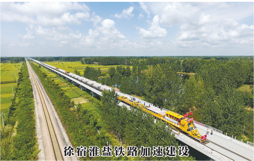
江苏腹地重要的铁路大动脉之一——徐宿淮盐铁路，连接江苏徐州、宿迁、淮安、盐城4市，线路全长约300余公里，全程设计行车速度为250公里/小时，预计2019年底达到通车条件。图为9月12日，徐宿淮盐铁路淮沭新河特大桥路段正式开始铺轨。
