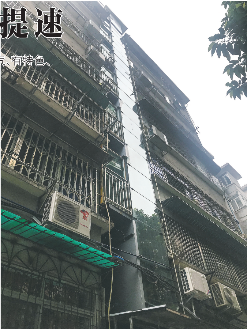
广州市越秀区坚持以人民为中心,加大改革创新力度,把“红色引擎助力老旧楼宇电梯加装”纳入“新时代越秀党建先锋行动”,自2009年以来,全区老旧楼宇累计加装电梯614台,其中,2018年已完工并核发电梯使用登记证62台,经规划部门许可并准备施工或正在施工的电梯共214台。图为老旧楼宇电梯加装施工现场。
