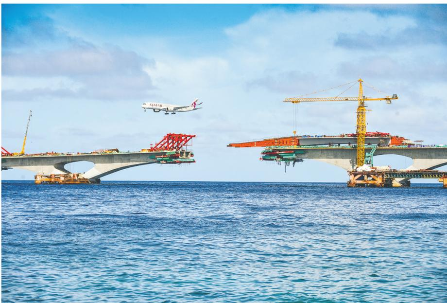
5年的发展与奋进，“一带一路”从理念转化为行动，连点成线到面，在广袤大陆上落地生根，在浩瀚海洋中乘风破浪，千年丝路再次焕发出蓬勃生机，为当今世界开启发展新航程……图为位于马尔代夫的中马友谊大桥主桥20号墩至21号墩之间的钢箱梁正在顶推中。
