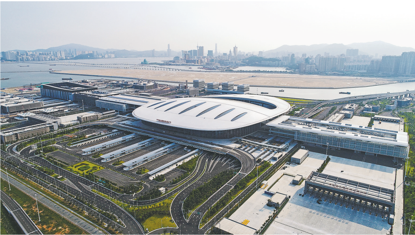
2017年7月1日,习近平总书记在香港亲自见证国家发展改革委和粤、港、澳三地政府共同签署《深化粤港澳合作 推进大湾区建设框架协议》。一年多来,“粤港澳大湾区”成为备受关注的热词,中国南方这片活跃度极高的经济热土,又以崭新姿态吸引了各界关切的目光。图为港珠澳大桥珠海公路口岸。
