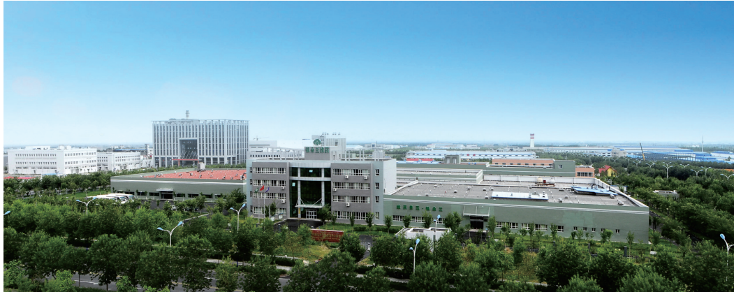
银朵兰维药厂区
