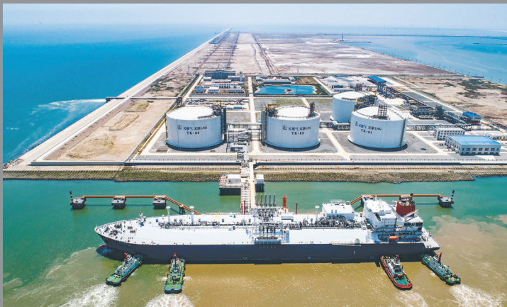
天津LNG 李 铮 摄
