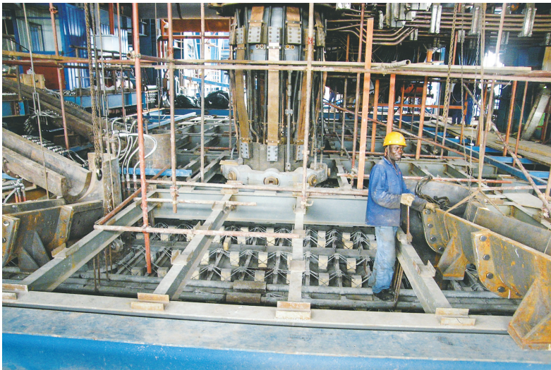
中色赞比亚 6300kva 沉降电炉示范工程
