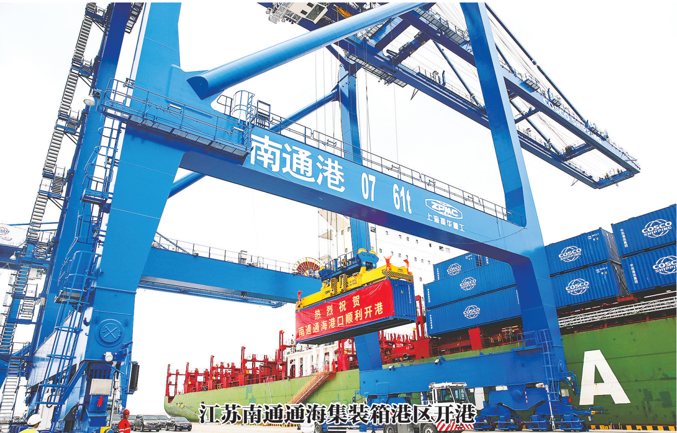
6月30日，由江苏南通港集团与中远海运港口有限公司联手打造的南通通海集装箱港区开港。该港区岸线长2478米，规划建设7个~8个7万吨级集装箱泊位，打造长江流域标杆性集装箱港区。图为南通通海集装箱港区。新华社发（许丛军 摄）
