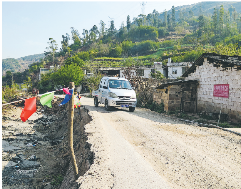
特殊的地质地貌,导致路面水毁严重,给管护带来了极大困难。
