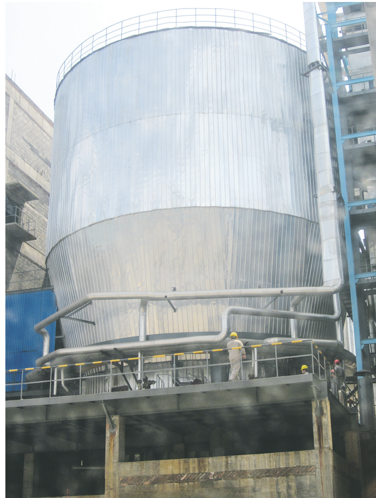
公司建造的 152 平方米锌焙砂沸腾炉炉衬；是现今世界上最大炉型，产品规格 55~60th 焙砂产量。
