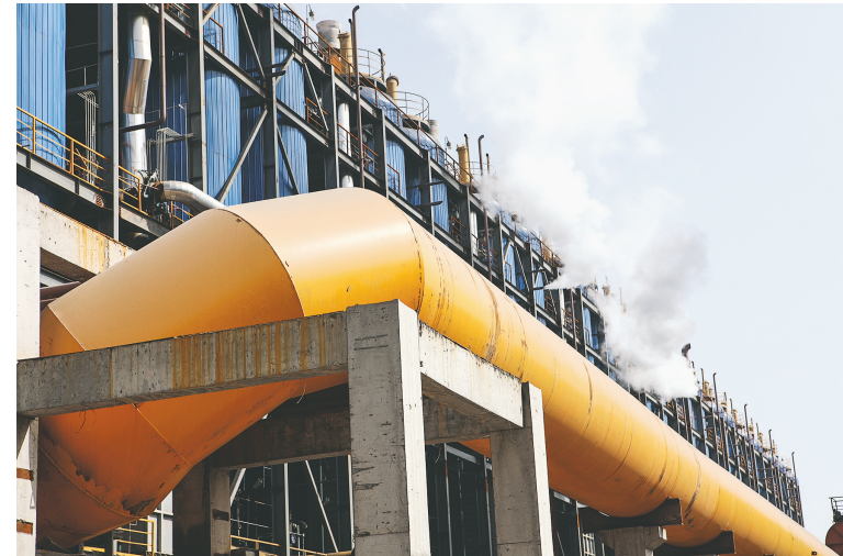
公司建造的交口肥美化工公司 10×2.0km³/h 循环流化床煤气炉示范工程(冷凝器及主炉体)
