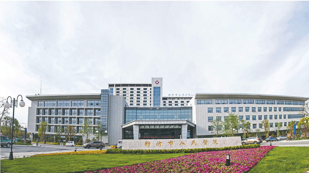
新沂市人民医院全景
