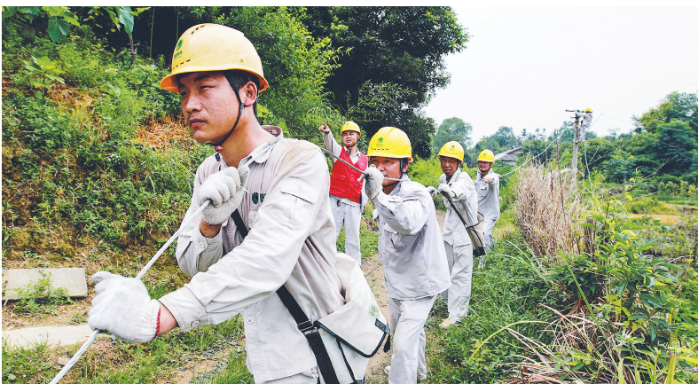
2017年6月13日,国网湘潭供电公司员工进行农网改造施工 周波 摄
