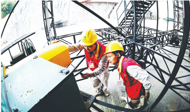
“共产党员服务队”开展保电前检查
