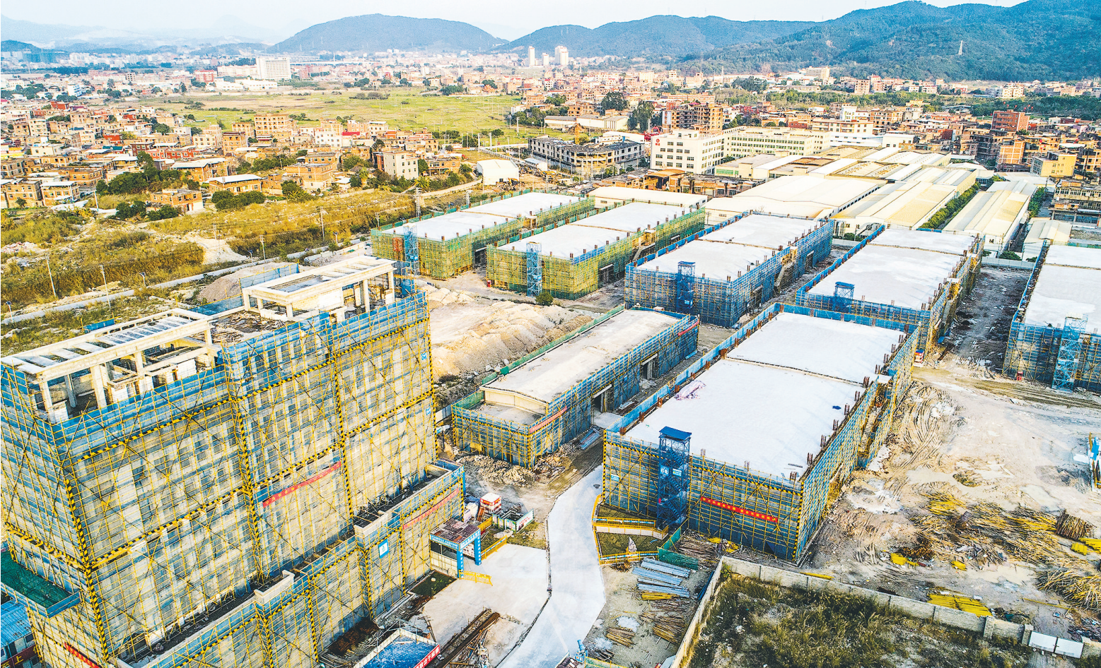
建设中的南安市储备粮中心库项目(泉州地区最大粮仓)
