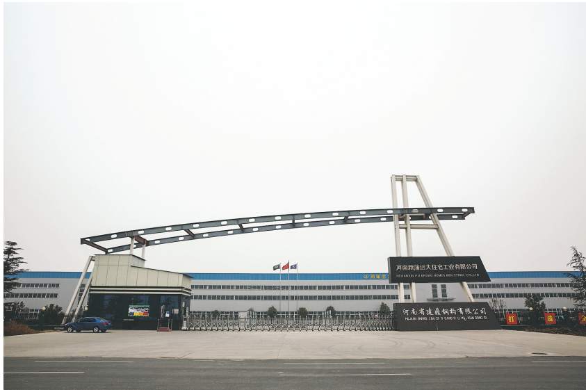
河南新蒲远大住宅工业有限公司已竣工投产
