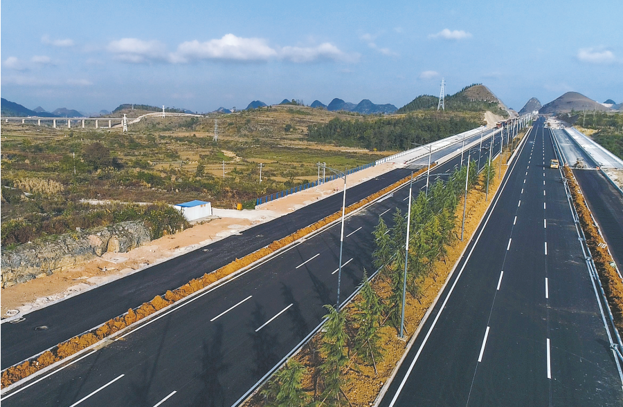
贵州分公司承建的安顺黄铺二标项目顺利通车
