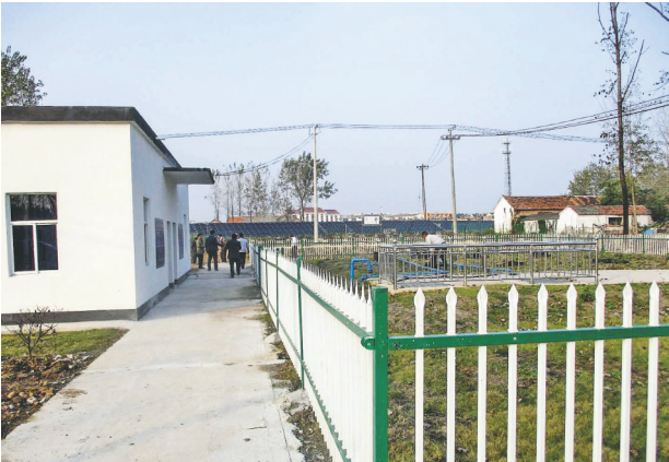
新修建的污水处理厂
