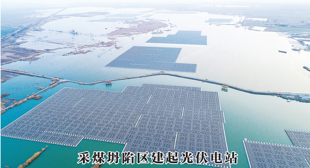
近年来,安徽省宿州市通过引进先进技术,发展采煤塌陷区水域光伏发电。2017年,中国与法国高科技节能企业共同合作在宿州市埇桥区朱仙庄矿区开展采煤塌陷区水域建设70兆瓦超大规模水上光伏发电项目,预计在2018年1月全部建设完成。图为朱仙庄矿区采煤塌陷区水域光伏发电项目。
