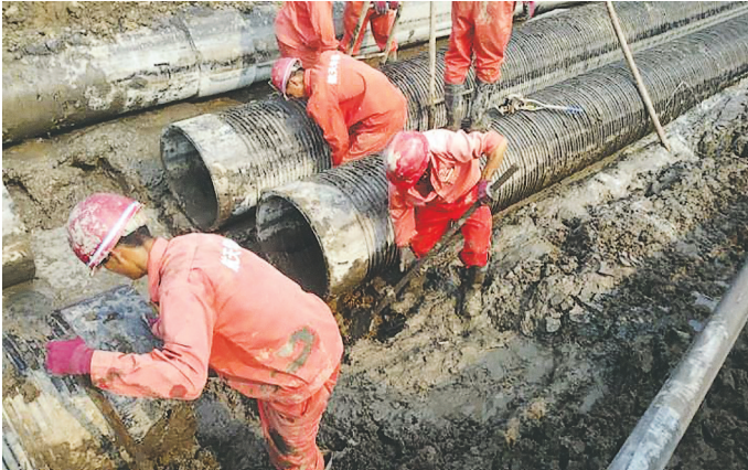
施工现场到处都是浑浊的泥水，一天换一身衣服是常事，一天换两身衣服也不少见。
