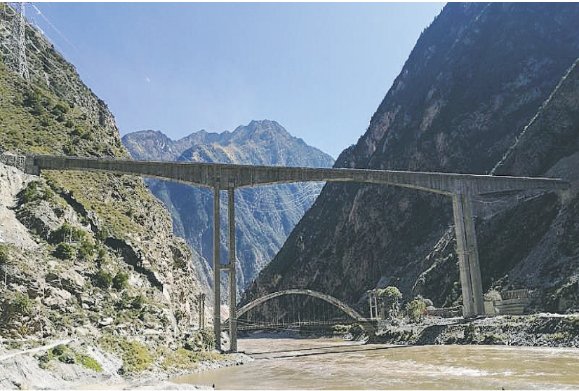
省道S211复建公路桥梁
